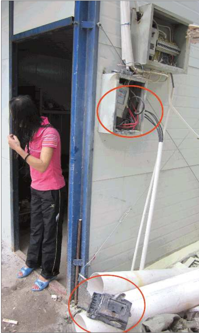
起火的电表箱里重新安装了一个电表,附近地面上还放着一个烧坏的电表。
