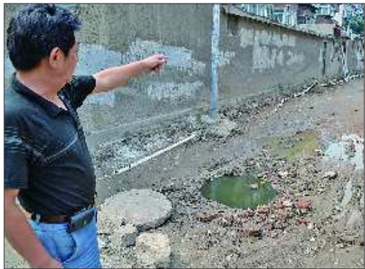
5日,杨庄东路2号楼斜对面向西的道路已经挖开,但施工一天又停工了。 本报记者 赵伟 摄
