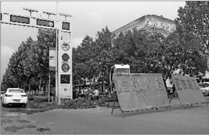
十三局门口施工现场
