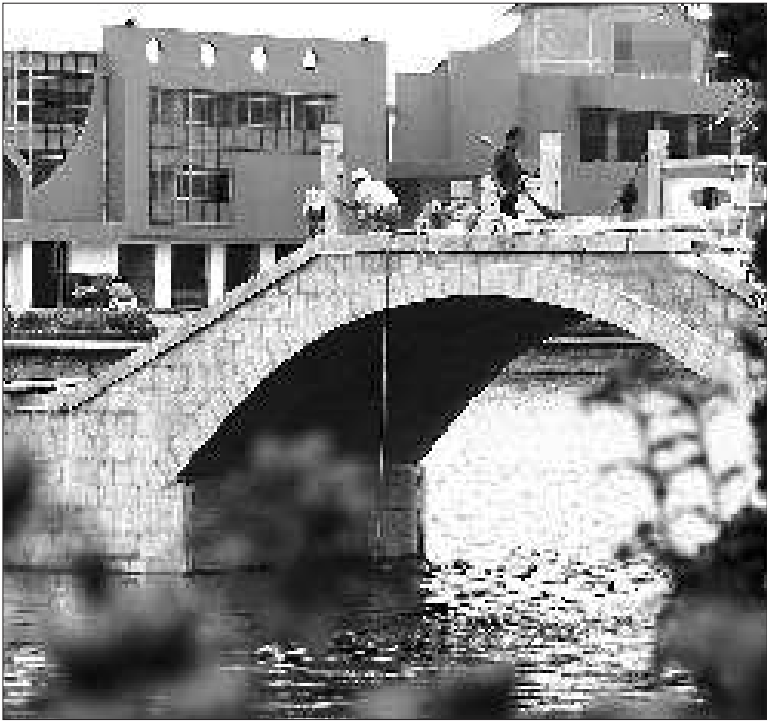
9月7日,施工人员正在对新湖上重建的小桥安装护栏。从6月份开建的新湖小桥现主体结构已完成,正在进行桥体装饰,预计“两节”期间可以完成。 本报记者 马志勇 摄
