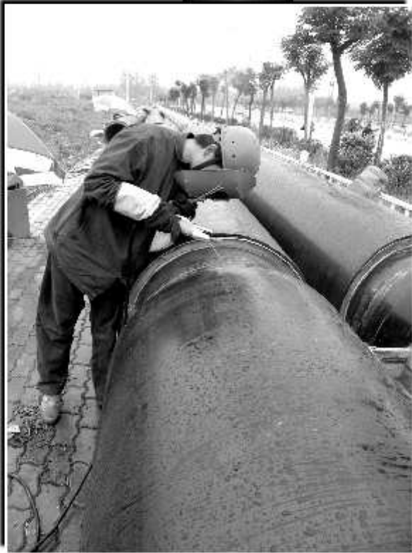
▲管道上的雨珠告诉我们,天空下着雨。
