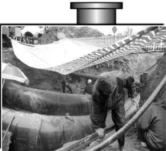
▲一块塑料布,保证施工不停歇。
