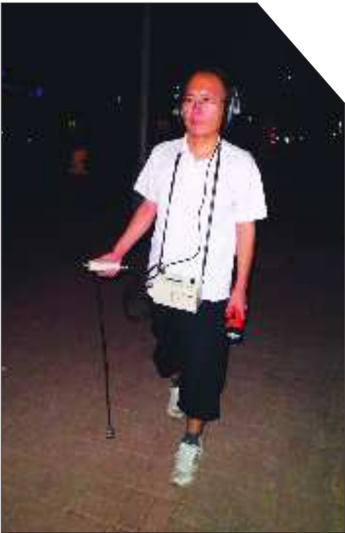
蔡长青在用听漏仪进行路面测漏。
