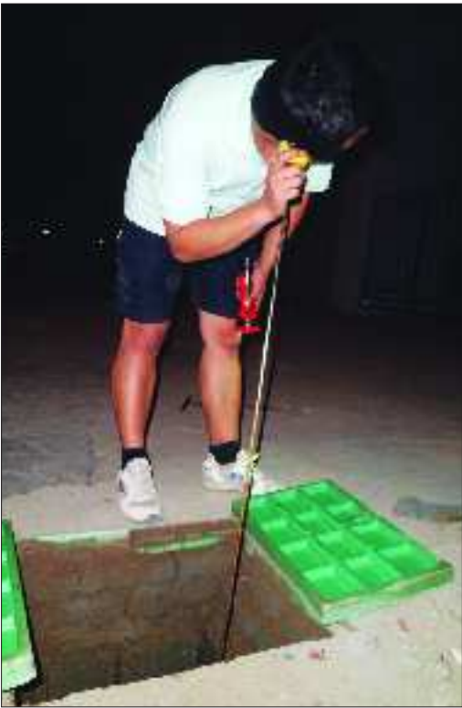
田亚飞在用听漏杆进行“阀栓听音”。
