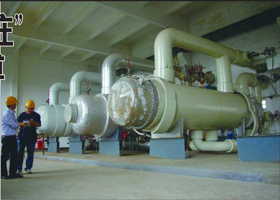
▲四台换热器将保证今冬的供暖。 ▼工作人员正在检修供暖设备。
