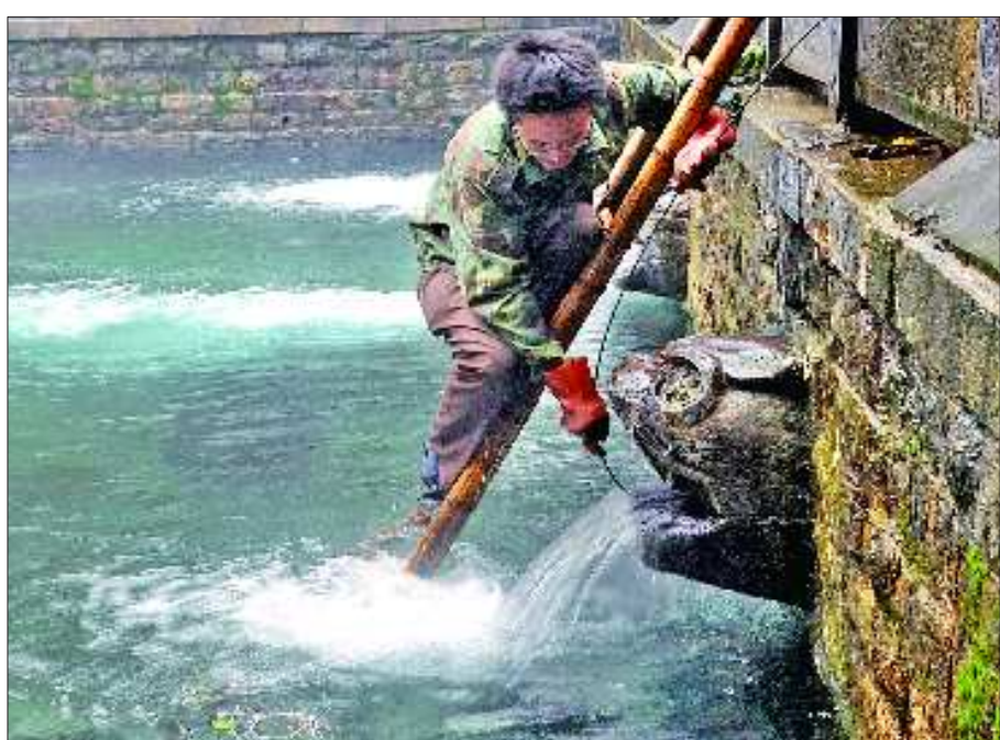
清噪 13日下午,工作人员对黑虎泉西侧虎口进行清理。近日,黑虎泉西侧虎头喷水量变小,原因是里面有大量盘根错节的树根,清理后情况有所好转。 本报记者 张中 摄
