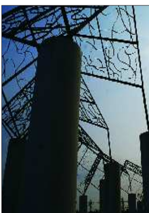
↑青岛啤酒文化广场内一角 ←施工人员正在加紧施工
