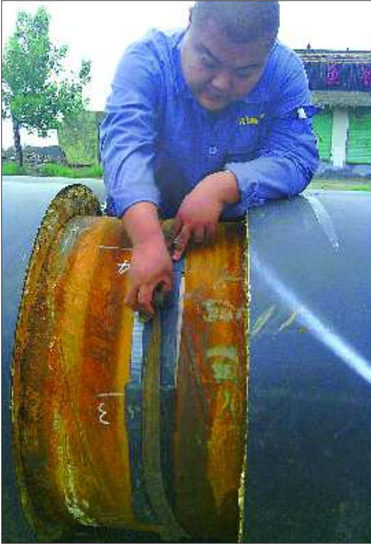
▲工人为焊接好的管口定上标记并固定好胶片,等待探伤检测。
