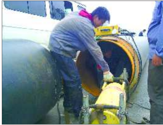
▲工人正将X射线探伤机头置于管线内部。
