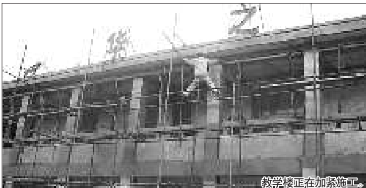
教学楼正在加紧施工。
