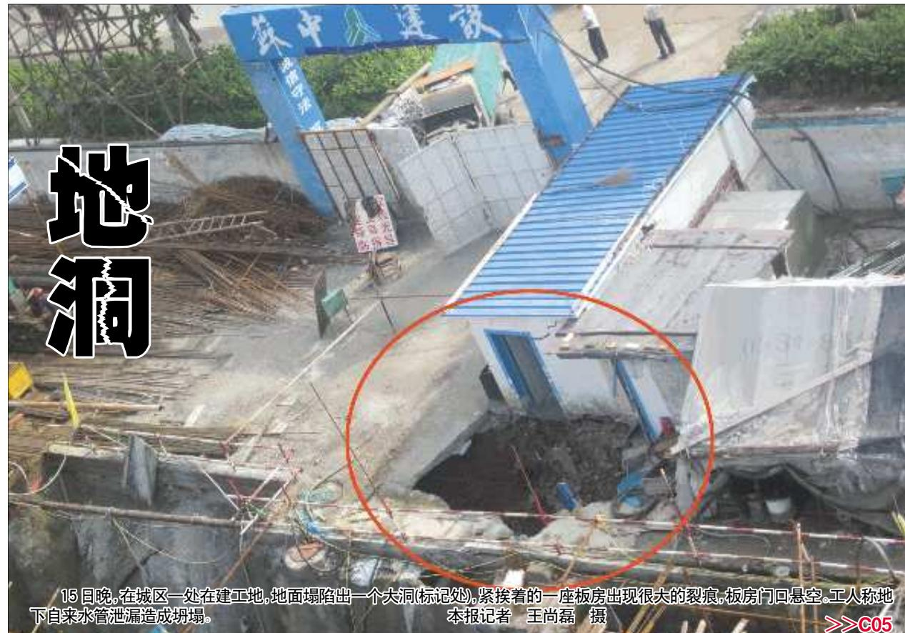
15日晚,在城区一处在建工地,地面塌陷出一个大洞(标记处),紧挨着的一座板房出现很大的裂痕,板房门口悬空。工人称地下水自来水管漏泄造成坍塌。 大连日报记者 王尚昆 摄
