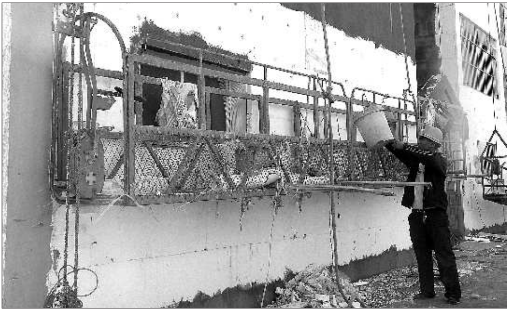
亨通园小区正在进行供热计量及节能设施改造。 本报记者 景佳 摄
