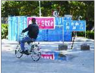
营子河西岸路段正在施工。 本报记者 贺超 摄
