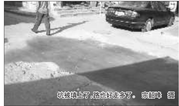
坑被填上了,路也好走多了。宗韶峰 摄
