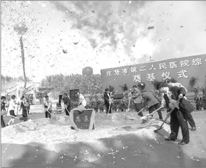
东营市第二人民医院综合楼奠基仪式现场,嘉宾们正在用铁锹挖土奠基。本报记者 王瑞景 摄
