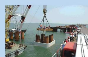
水下无封底混凝土套箱技术施工
