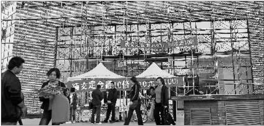
9月20日,苏宁电器的门面装修和开业前的预热宣传正在紧张进行中。 本报记者 马志勇 摄
