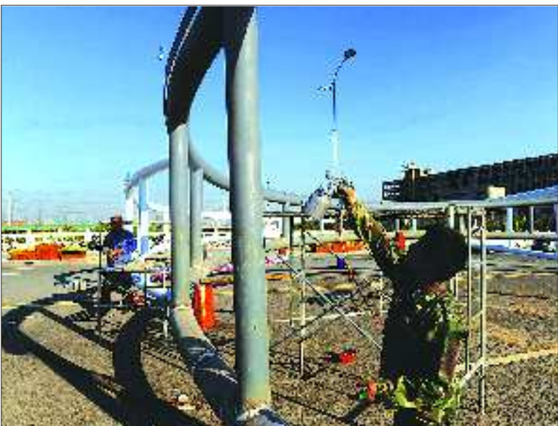
22日,小清河五柳岛附近,工人们正在安装大型桥梁构架。 本报记者 周青先 摄
