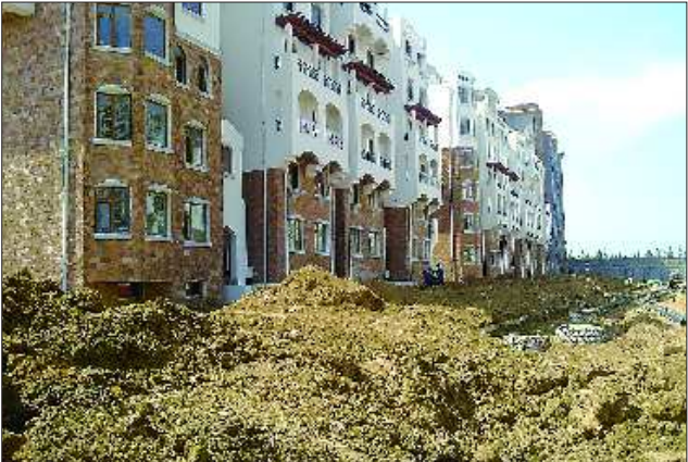
23日，西班牙公馆还在施工当中，楼前楼后全是铺设管道挖出的土堆。
