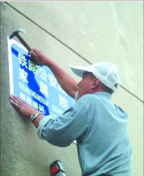
工作人员正在安装新门楼牌。
