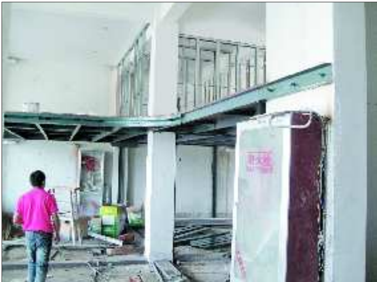
商铺室内改造的情形。记者 张冬梅 摄
