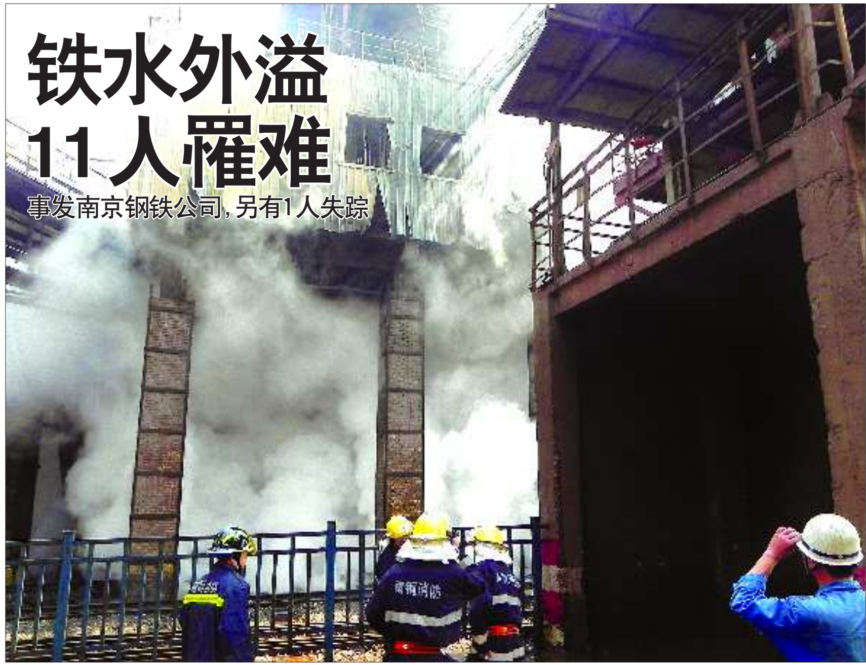
5日11时45分许, 位于南京江北的南京钢铁股份有限公司炼铁厂5号高炉在淘汰停炉过程中, 炉中剩余铁水击穿炉壁流出, 高温铁水形成气浪, 造成人员伤亡。截至当天20时, 事故共造成11人死亡、1人受伤, 另有1名失踪人员仍在搜索中。 新华社发
