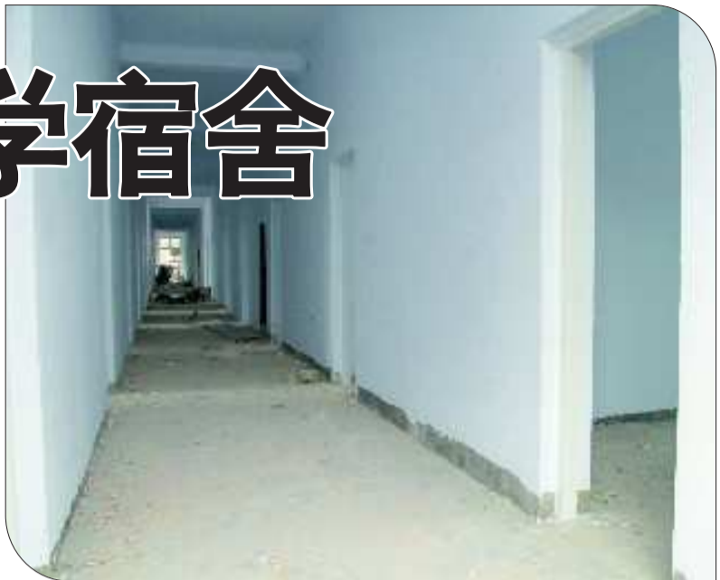
公寓内部墙壁已经粉刷完毕。
