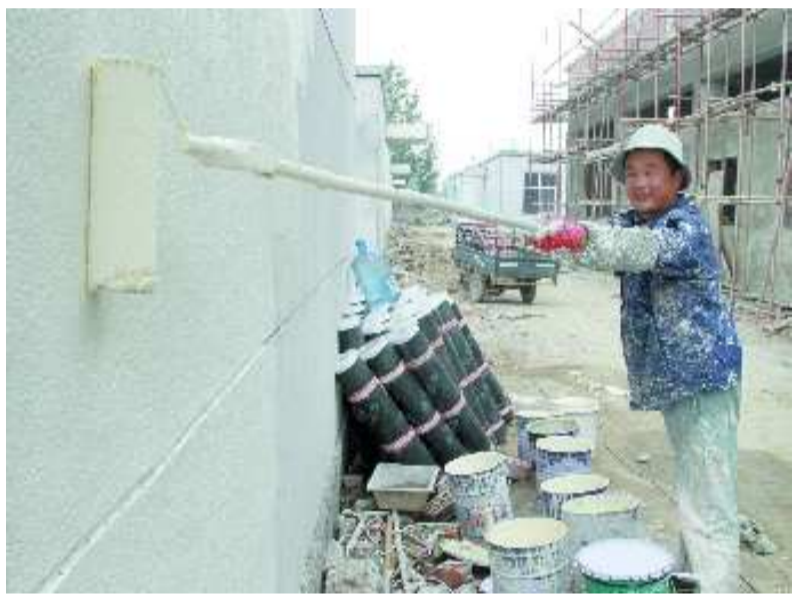
施工人员正在粉刷公寓外墙。
