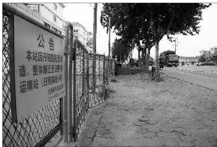
位于G204拓宽拆迁范围内的日照客运南站已搬迁,里面挺冷清。 记者 刘涛 摄
