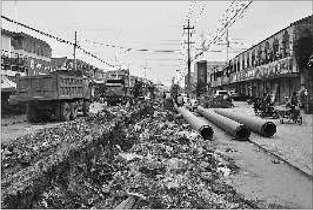
挖路为供暖 10日,在市中区永安新型社区附近,道路开挖,工程车占道,给市民出行带来很大不便。据了解,道路开挖是为了铺设暖气管道,以便让更多的市民冬季能用上暖气。 本报见习记者 武春澍 摄
