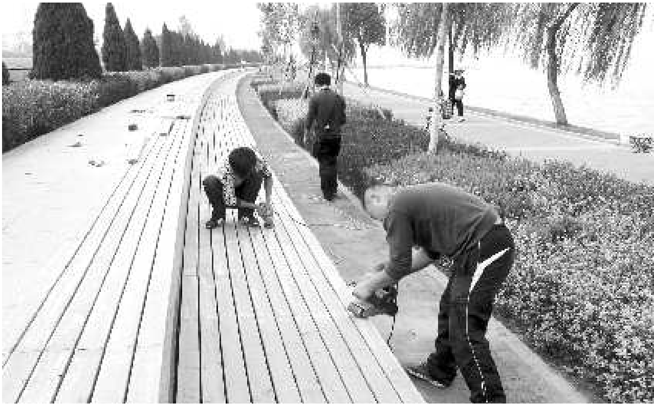
11 日下午，滨河景区沂蒙广场附近，市园林局小埠东管理所的工作人员在用砂光机、磨光机打磨木质坐凳。工作人员称，这次打磨主要是为了磨掉木凳表面的木刺，使市民坐在木凳上休息时不会被木刺刮伤衣物。打磨结束之后，他们还会在木凳上刷防腐剂，再刷两层清漆。所有事项完工大约需要一星期时间。 记者 姜雅哲 摄影
