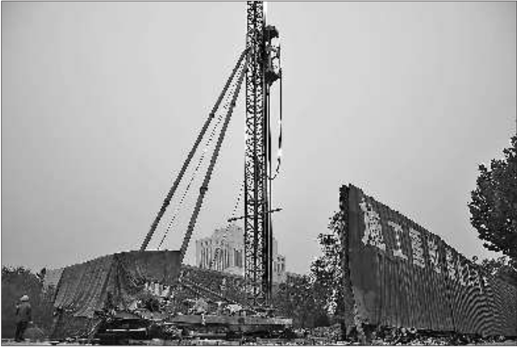
学院西路人防工程施工现场。 本报记者 苏超 摄
