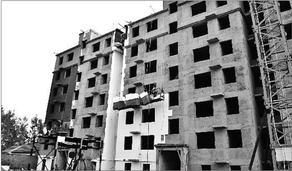
11日，学苑路公租房已进行外墙保温材料覆盖。 本报记者 张永斌 摄
