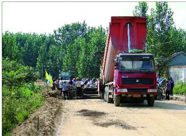
▲洛河至安庄段基层摊铺现场
