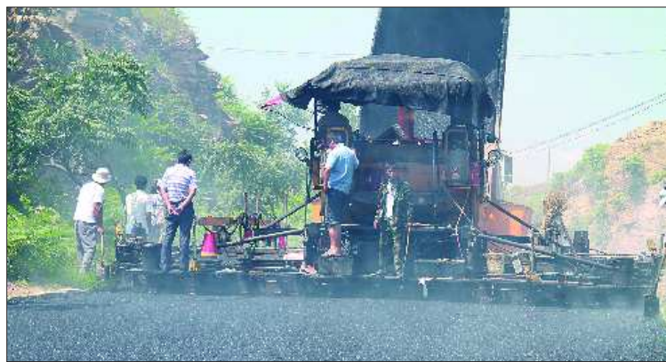
▲洪营线桑园段中修沥青罩面现场
