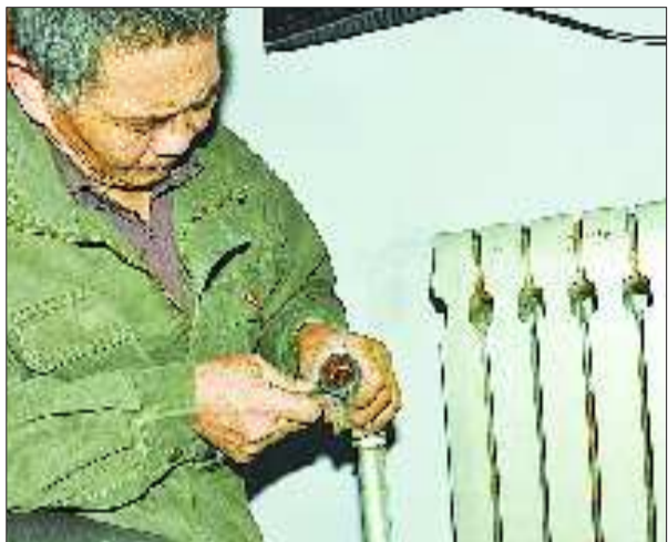
供热公司工作人员正在用工具刮垫。本报记者 熊戈措 摄
