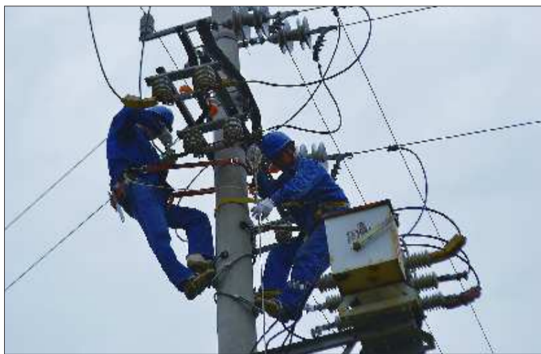
城关供电所工作人员正在为山庄村新变变压器接火。本报记者 李玉涛 摄
