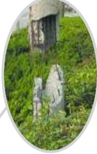
13日,有市民反映,渤海九路黄河一路和黄河二路间路北的18路站牌处,有一根水泥杆只靠几根锈蚀的钢条支撑,随时都可能倒,存在很大的安全隐患。
