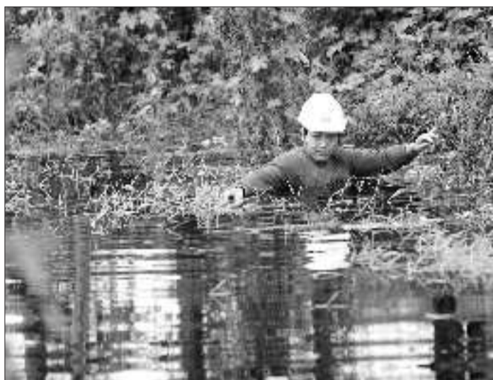
13日,记者从滕州供电部了解到,为加强土地资源整合,12日起供电部在滕州规模最大的机械工业园区将分散的高压线路进行适度集中,图为在线路迁改过程中,施工人员跳进水沟,涉水完成放线紧线任务。
