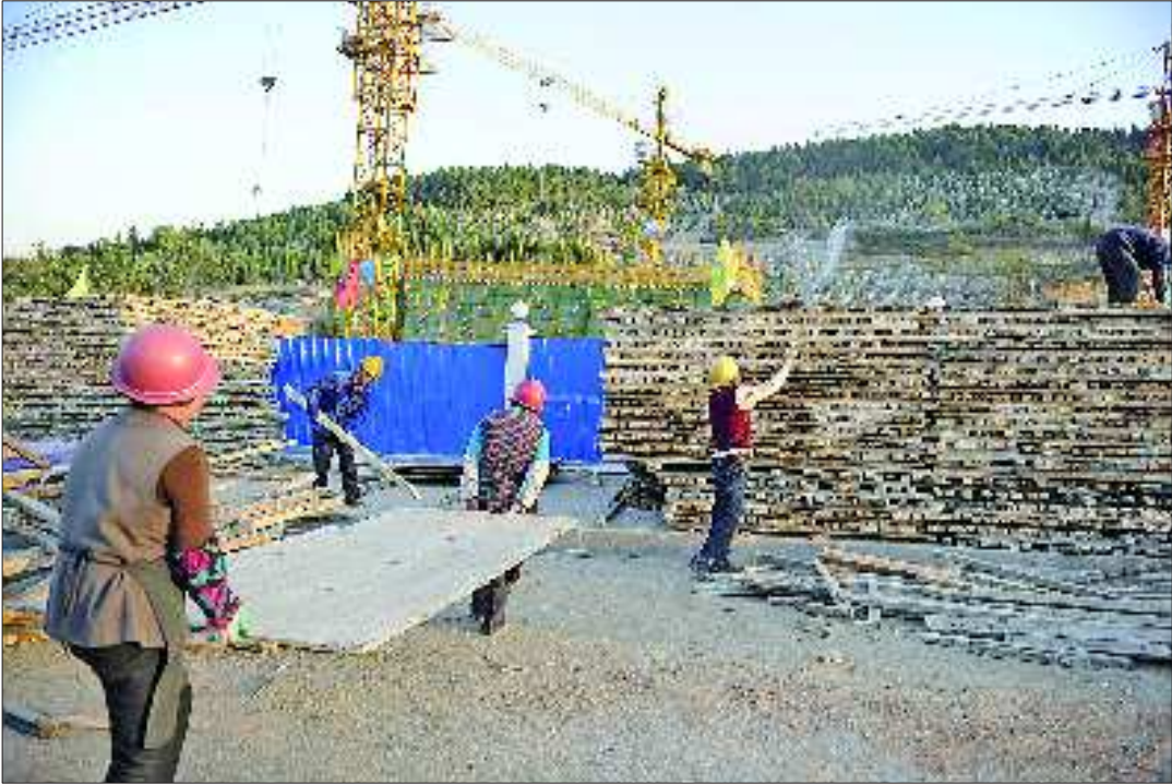
在位于旅游路以南、龙洞路西侧西蒋峪片区的公租房建设施工现场,工人们正在紧张施工。 本报记者 王媛 摄
