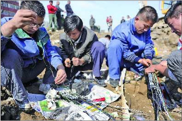
联通公司工作人员正在抢修被挖断的光缆。 本报记者 王媛 摄
