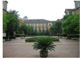
参观时,记者看到,整个建筑立面采用法式风格,全部采用石材干挂,石材选用一期工程中广泛使用的卡拉麦里金,外立面典雅、大方,坡屋面采用与学校一样的深灰色平板瓦具有浓郁的异国情调。
