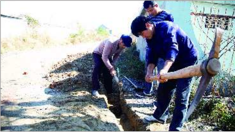
村民正在挖铺设新水管的沟。 本报记者 刘涛 摄
