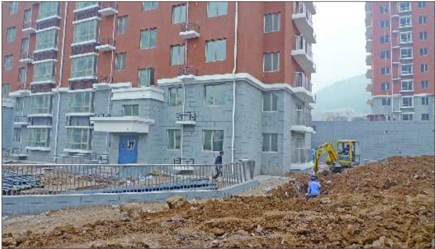
小区主体已完工,各种管道还在铺设。 喻雯 摄
