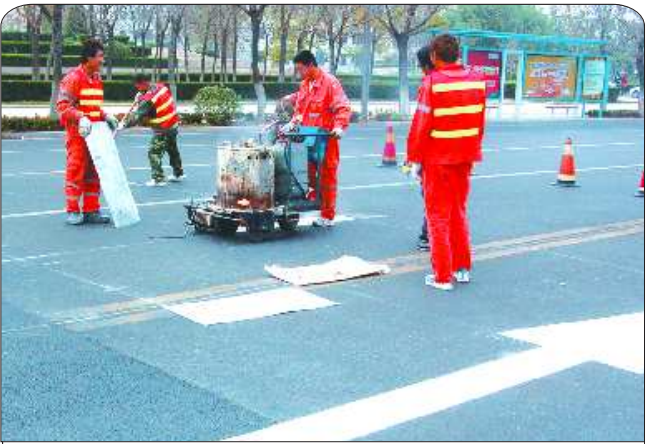
3日,工作人员正在府前大街新修的路面上,画交通指示线和人行横道。一名过路人说:“前几日就是在这里发生了几起事故,划线后过马路就安全了。” 本报记者 段学虎 摄影报道
