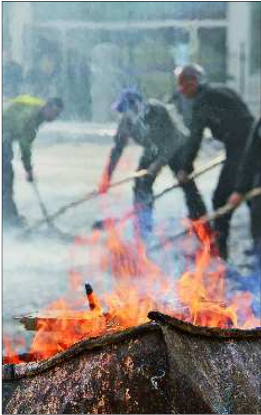
燃起火堆烤一下铺沥青的工具。
