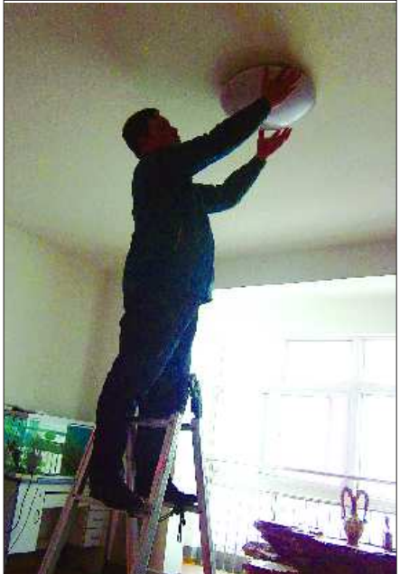
金泉大厦物业的一名工作人员正在给业主修灯,发现灯罩脏了,就提醒业主顺便做做清洁。本报记者 孟敏 摄
