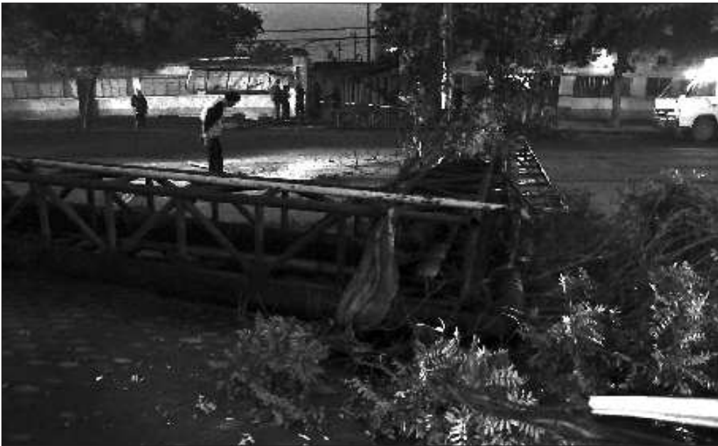
管道塔倒地。 本报记者 苏超 摄
