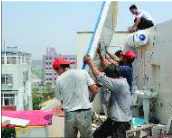
拆除北村小区9号楼楼顶违法搭建。
