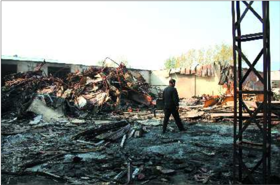
板厂被烧成一片废墟。
