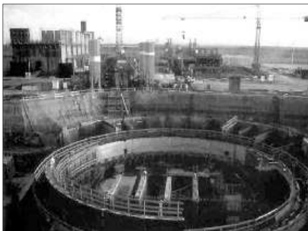
伊拉克奥西拉克反应堆建造工地。
