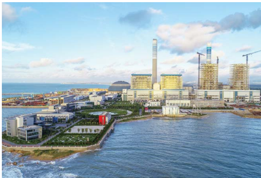
智慧生态美丽电厂—华电莱州发电有限公司
