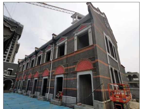
上海石库门施工实景图
