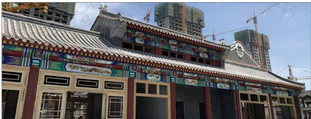
北京四合院施工实景图
