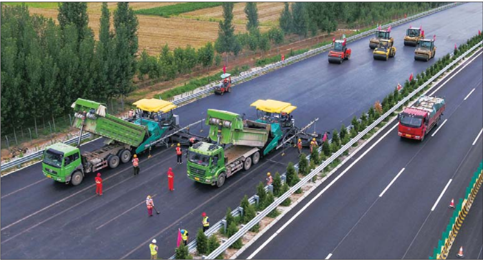
滨莱高速正在进行沥青铺设作业。 本报记者 王瑞超 摄
