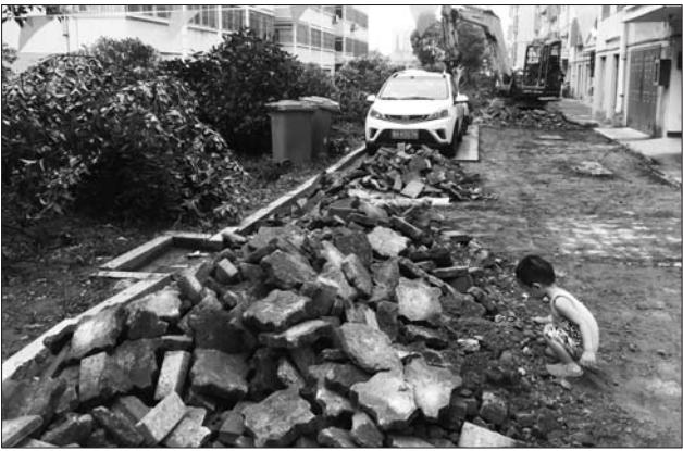
鲁兴花园小区内,破损的路面正在维修。 齐鲁晚报·齐鲁壹点见习记者 崔培 摄
